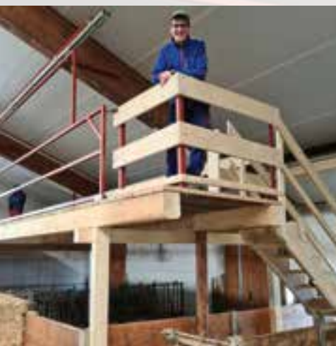
Max Hintner aus Schlingen hat zur Strohlagerung eine hochziehbare Treppe an der Bühne gebaut.
