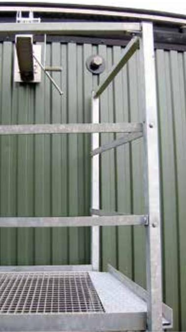
An den Entnahme- und Rührstellen von Erdbehältern und Lagunen muss ein 30 cm hoher Anfahrsockel vorhanden sein. Ferner muss auch während des Aufrührens oder der Entnahme ein Hineinstürzen von Personen in den Erdbehälter bzw. die Lagune verhindert werden (dieses kann z. B. ein Schieberelement oder eine Klappe in der Umwehrung sein).
