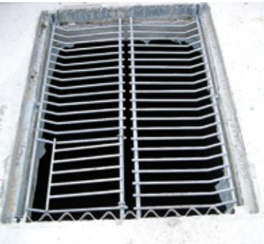
Als Abdeckungen können auch unverschiebbare Roste mit einem Stababstand von maximal 5 cm eingebaut werden. Wird die Öffnung wegen Geruchsbelästigung abgedeckt, so sollte der Rost unter der zusätzlichen Abdeckung verbleiben.
