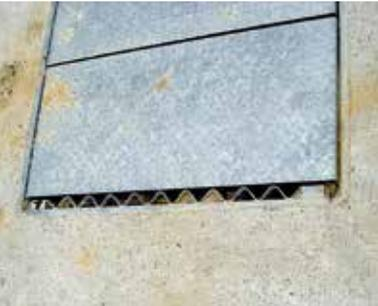
Entnahme- und Entlüftungs- bzw. Kontrollöffnungen von Güllekanälen, Erdbecken und Güllebehältern sind so einzurichten, dass sie auch im geöffneten Zustand (z. B. zum Einbringen von Rühr- und Entnahmeeinrichtungen und Güllearbeiten) gegen Hineinstürzen von Personen gesichert sind.
